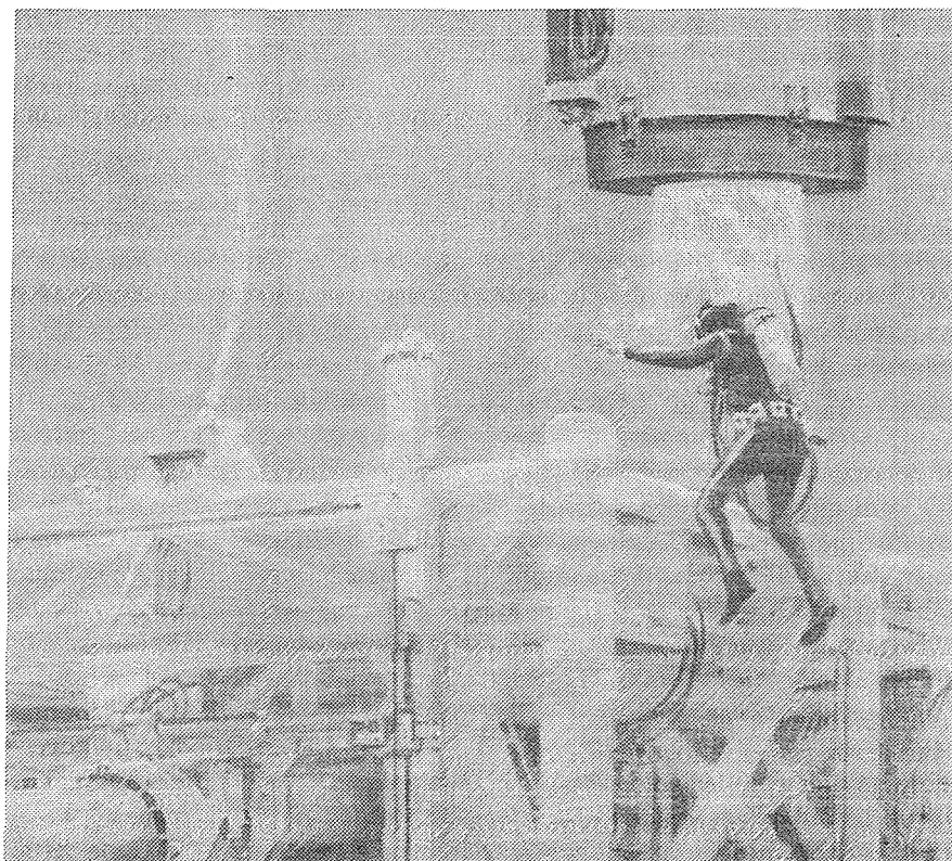
Diver approaching welding habitat.
