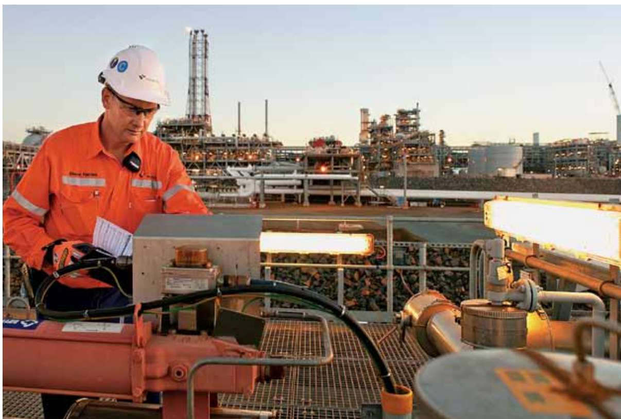
Pluto LNG oshore gas plant.
